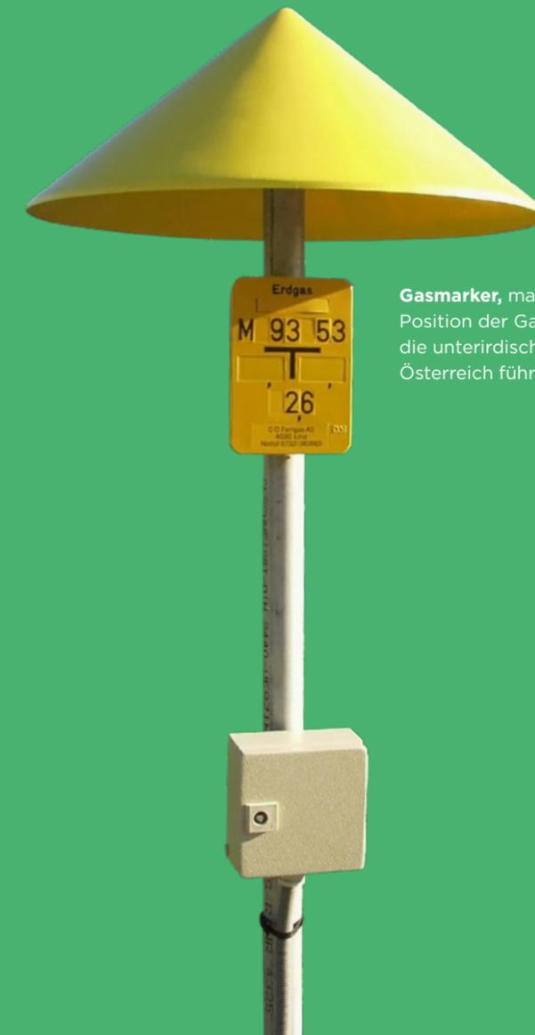
**Gasmarker**, markiert die Position der Gaspipelines, die unterirdisch durch Österreich führen.
